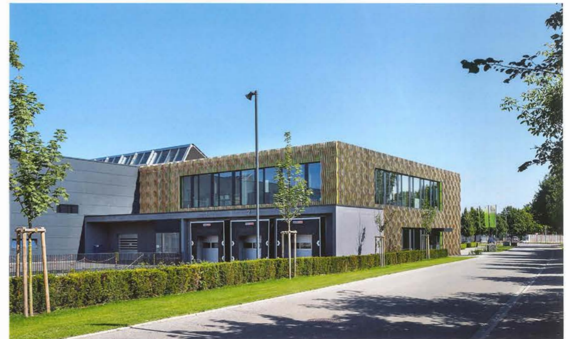
Bereich Lkw-Hof und Anlieferung mit Verladebrücken
