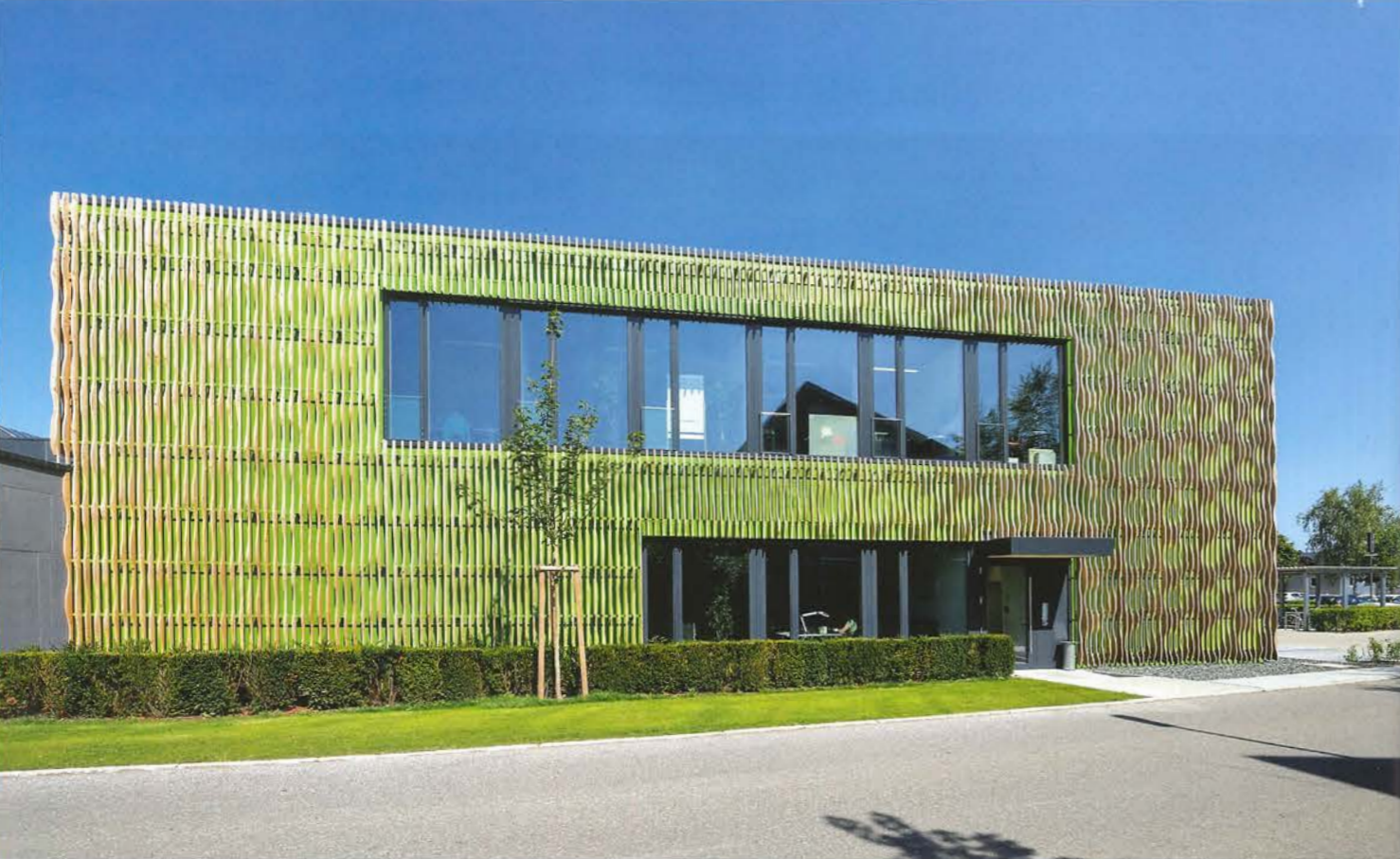
Durch die Modulation der Lattung vor der Fassade erhält das Gebäude je nach Blickwinkel eine andere Anmutung.
