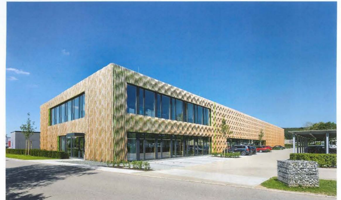
Lange Seite – im Vordergrund der Bürobereich des Logistikzentrums
