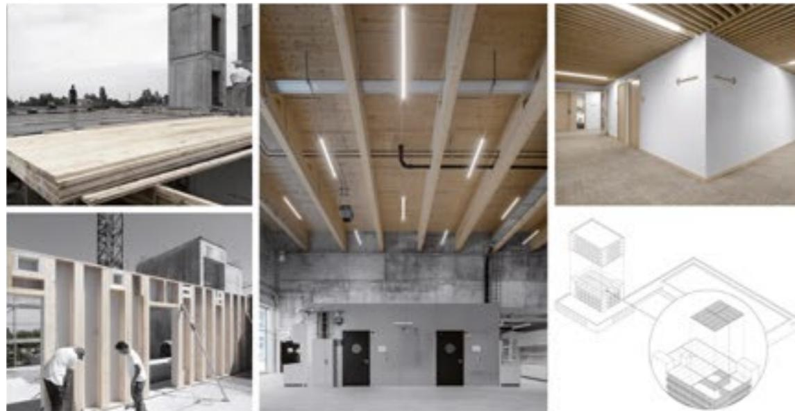
Tragkonstruktion aus Holz
