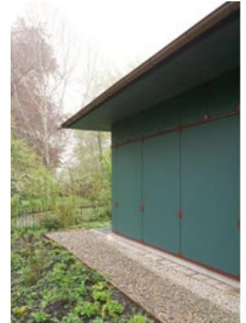
Die den Stoffbahnen eines Zelts gleichende Holzfassade wird von roten Broschen gehalten.
